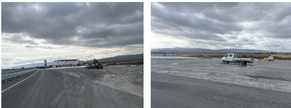
石梯子停车区建设情况
