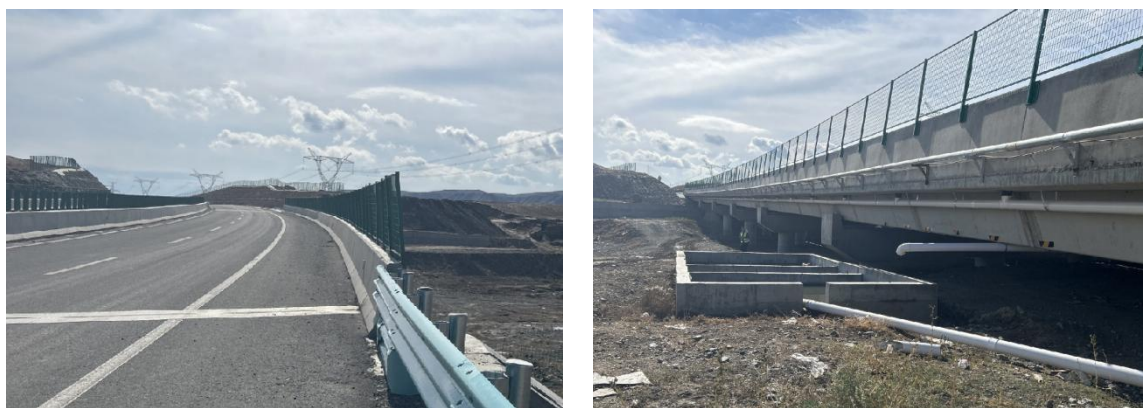
独山子大桥建设情况
