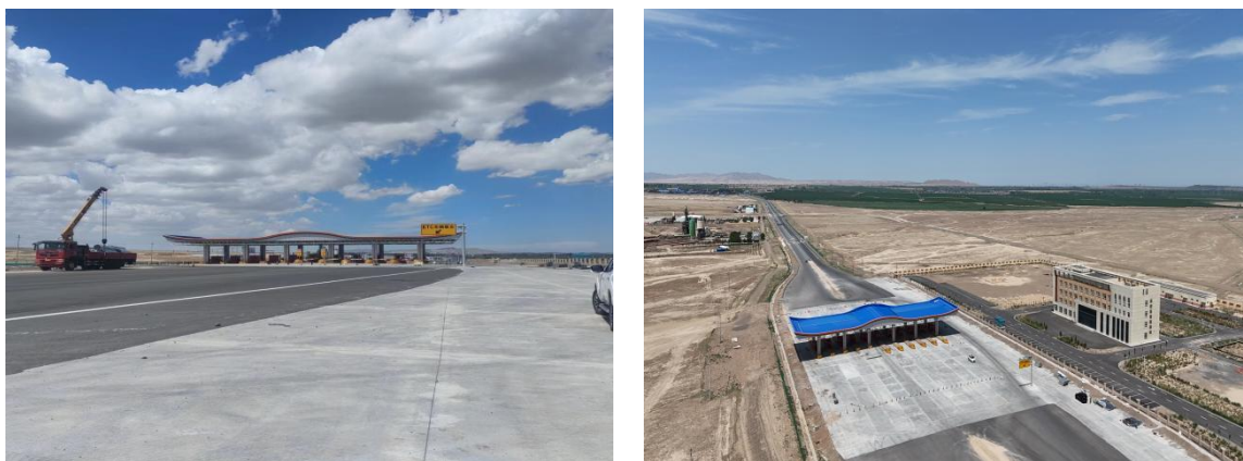
呼图壁主线收费站建设情况
